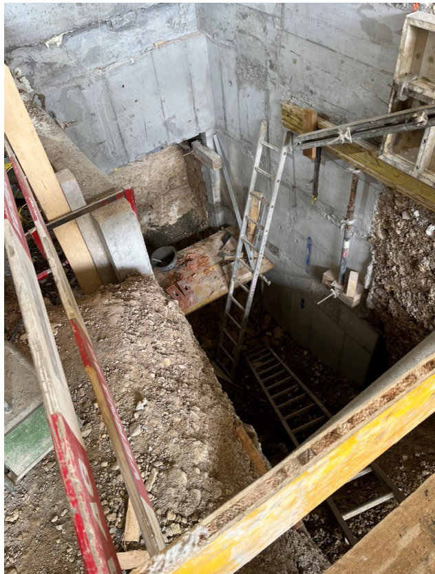
Blick in den Liftschacht, eingebaut im ehemaligen Pfarrsaal
