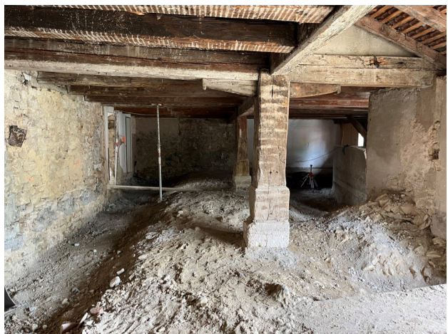
Blick in den zurückgebauten nordseitigen Raum des ehemaligen Ökonomieteils mit sichtbarer Oberseite des Kellergewölbes
